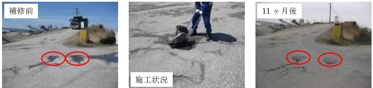
写真-5 砕石製造工場内での試験施工
