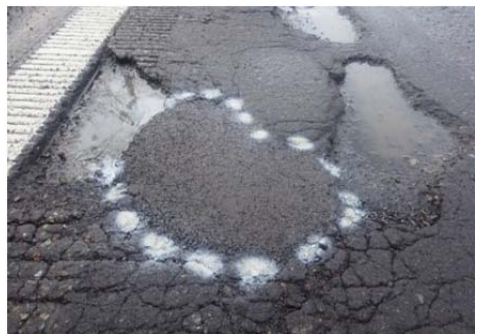
写真-5 供用1ヶ月後状況(改良品2)
