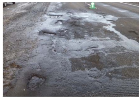
写真-3 施工前状況
