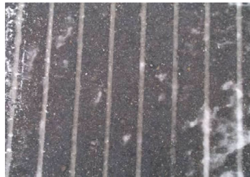
写真-11 路面状況 (拡大)
