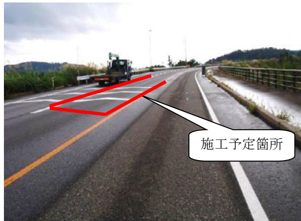
写真-1 施工箇所の写真
