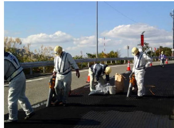
写真-7 余剰ゴムパウダ回収状況
