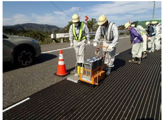
写真-3 特殊接着剤散布状況
