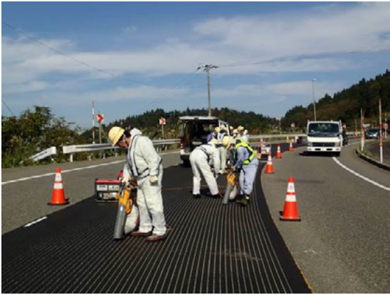
写真-2 路面清掃状況
