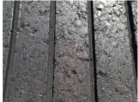
写真-9 施工完了面
