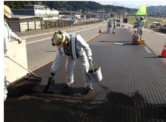
写真-5 ゴムパウダ散布状況
