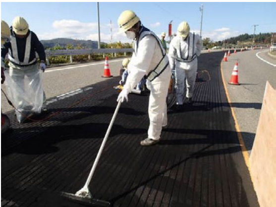
写真-6 ゴムパウダ敷き均し状況
