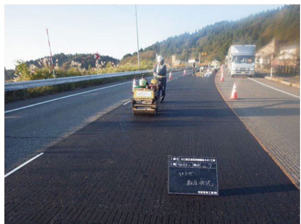
写真-8 仕上げ転圧
