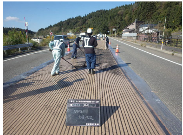
写真-6 凍結抑制材の充填
