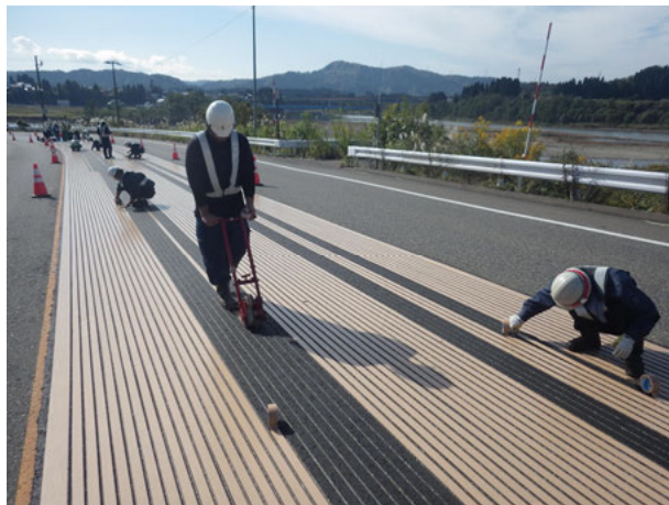
写真-3 テープ養生
