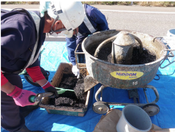
写真-5 凍結抑制材の製造
