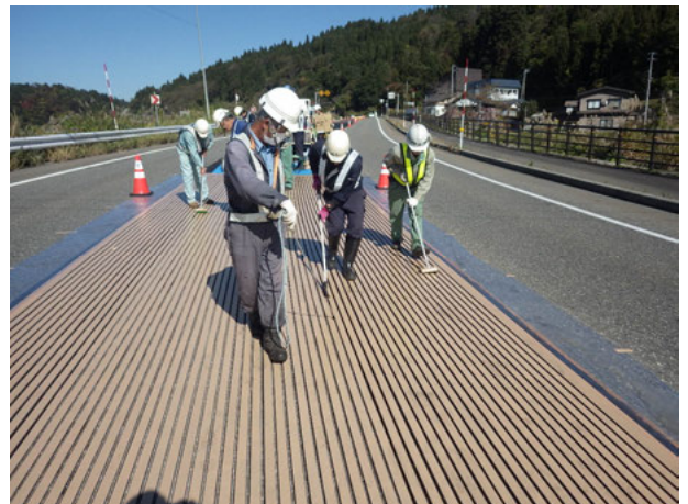
写真-4 プライマー塗布
