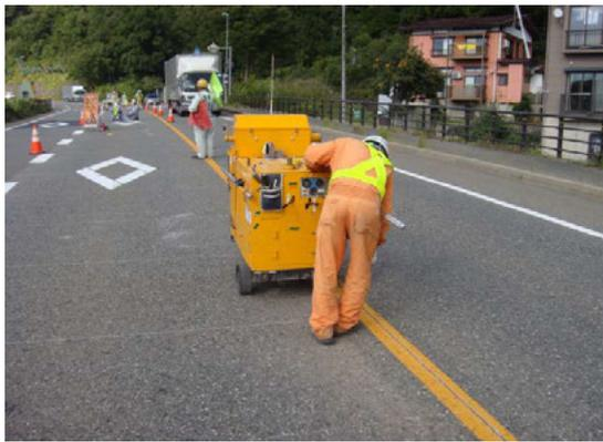
写真-1 端部縦グルービング切削状況
