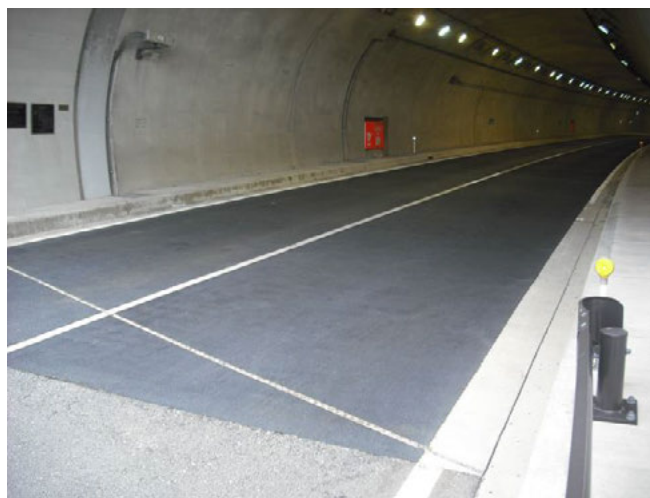
写真－６ 施工１年４ヶ月（２冬）経過状況
