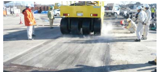
写真-2 試験施工の施工状況
