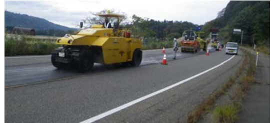
写真-3 実道での施工状況(国道17号)
