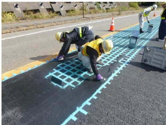
写真-7 ウレタン樹脂の充填状況
