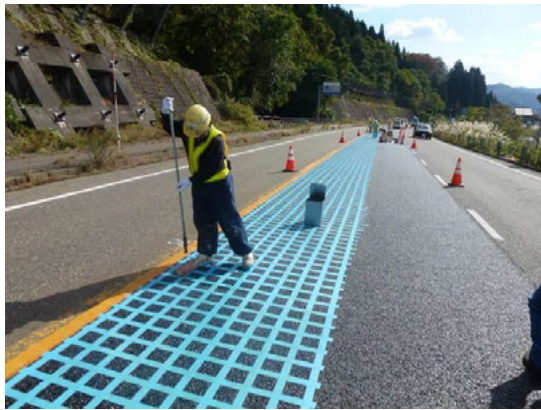
写真-5 プライマー塗布状況
