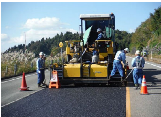
写真－1 多機能型SMA 敷均し状況
