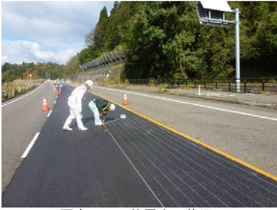
写真-3 位置出し状況
