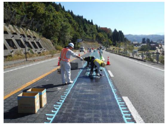
写真-8 珪砂散布状況
