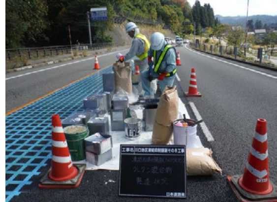
写真-6 ウレタン樹脂混合物の製造状況
