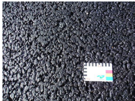
写真－2 多機能型SMA 仕上がり路面
