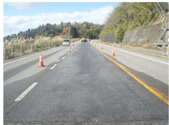
写真-2 現場状況
