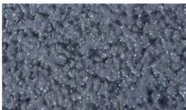
写真-6 路面状況
