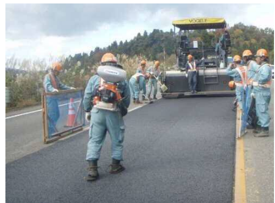
写真-4 養生用人工骨材散
