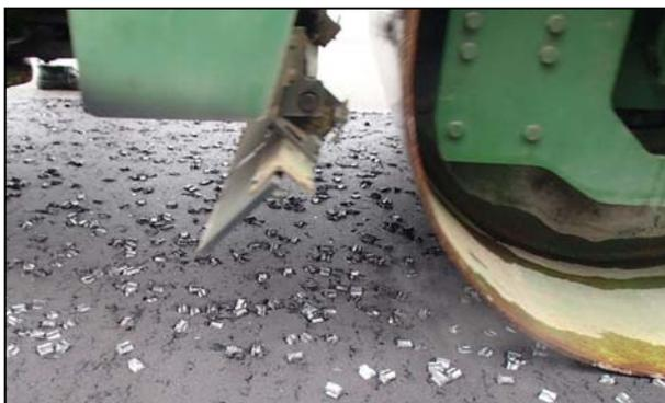
写真-6 ゴム骨材圧入状況（前輪ローラ後部）
