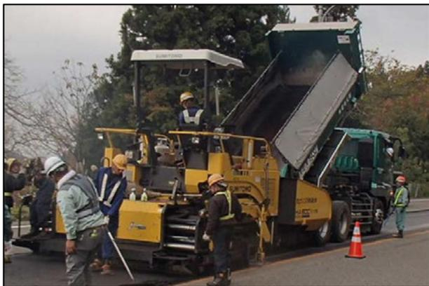
写真-3 ベースアスファルト混合物敷きならし状況
