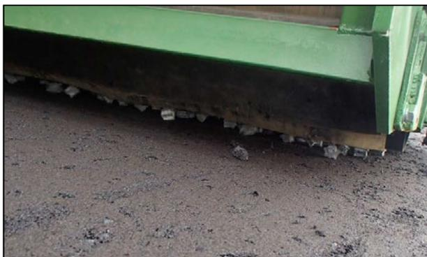
写真-5 ゴム骨材散布状況（チップングローラ前部）
