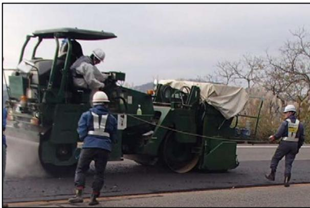
写真-4 ゴム骨材散布、圧入状況
