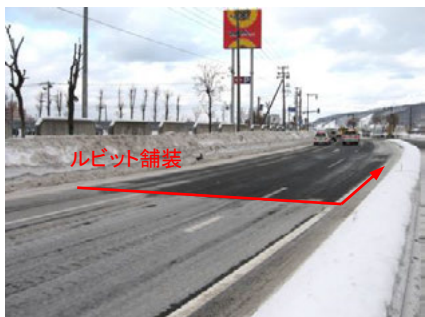
写真-3 一冬目路面状況(北海道)
