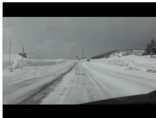
写真-12 一般舗装部の冬期路面状況
