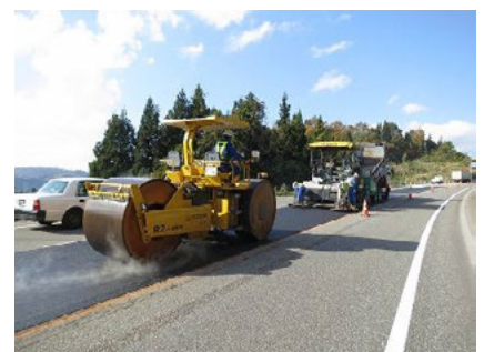
写真-7 初期転圧状況
