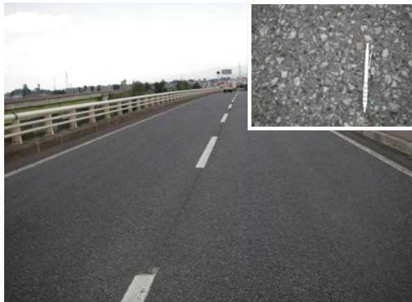
写真-1 供用後14年経過したルビット舗装
