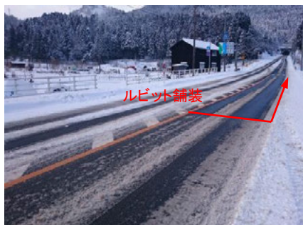
写真-4 二冬目路面状況(北陸)
