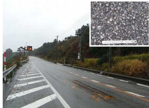
写真-2 供用後7年経過したルビット舗装
