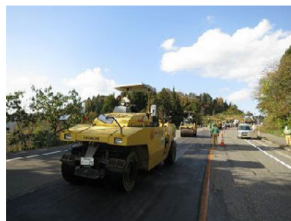
写真-10 仕上げ転圧状況
