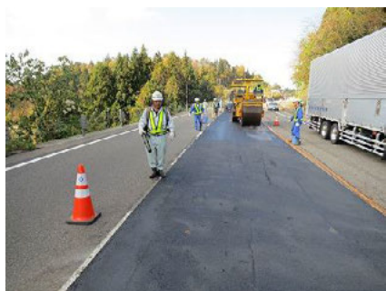
写真-8 硬質骨材散布状況
