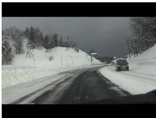
写真-11 ルビット舗装の冬期路面状況
