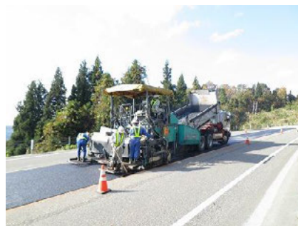
写真-6 敷きならし状況
