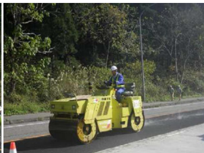
写真-6 初期転圧状況
