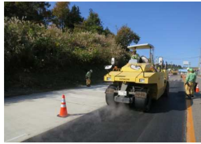
写真-8 仕上げ転圧状況
