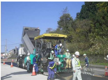
写真-5 敷ならし状況
