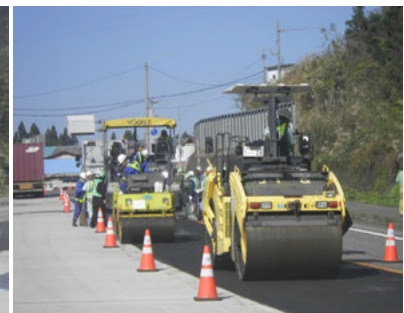
写真-7 二次転圧状況
