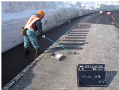
プライマー塗布
