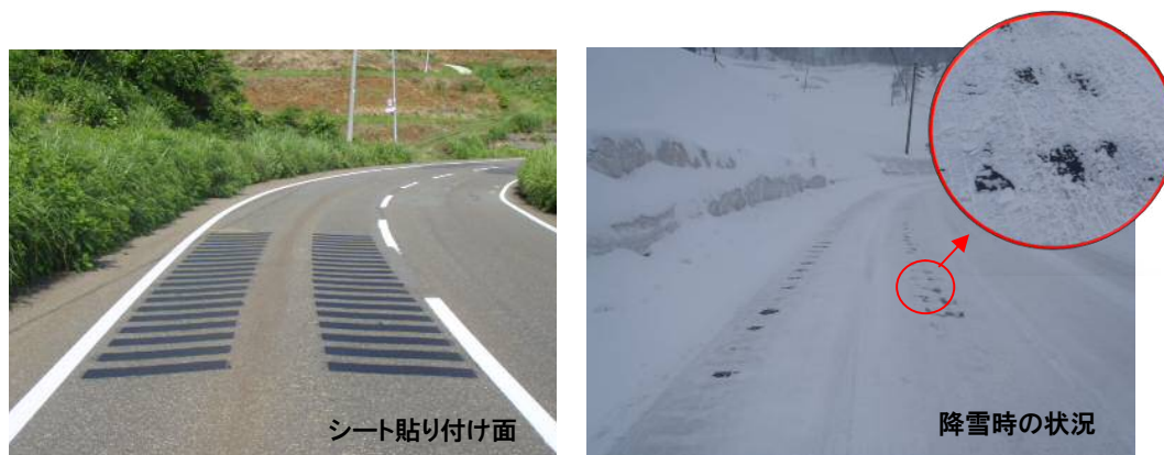
写真-4 シート貼り付け面および降雪時の状況
