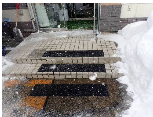
写真-7 階段に使用した事例
