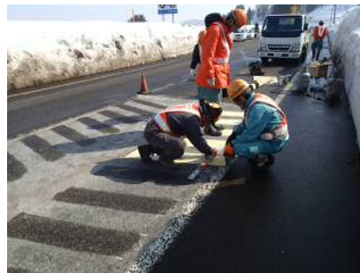
シート貼り付け 写真-2 施工手順
