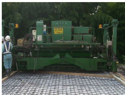
写真-4 増厚用コンクリートフィニッシャ
