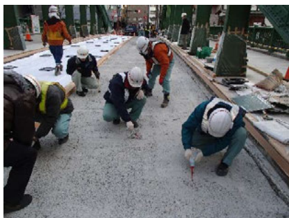
写真-7 ひび割れ補強状況
