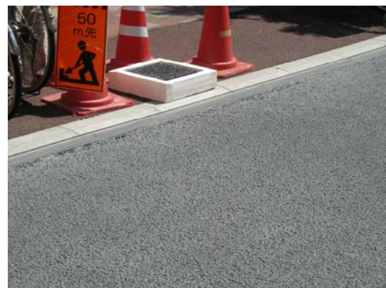
写真-5 舗装路面のサーモグラフィ画像例
