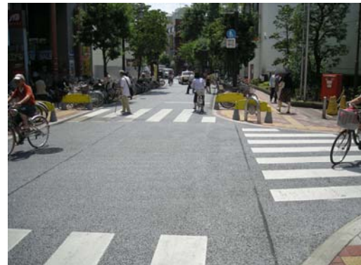
写真-4 本工法の施工場所状況例 (1期)
