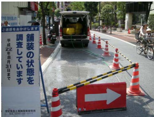
写真-1 現地調査状況例 (事前散水)
