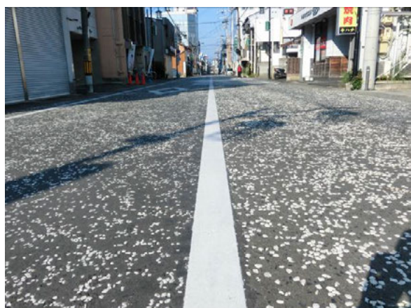
写-5. 明色ロールド舗装
