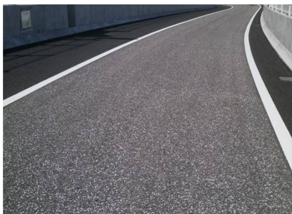
写-1. 排水性明色舗装
