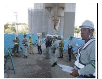
「喜屋武高架橋下部工 補強工事」の現場
