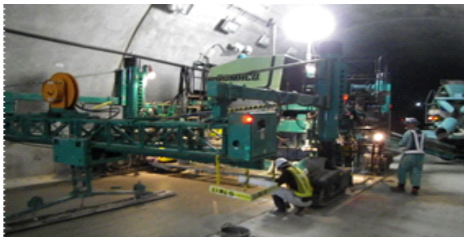
スリップフォーム成型機での施工
