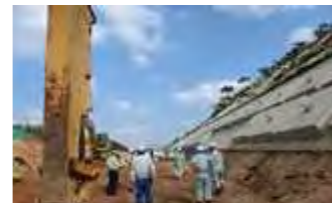
南恩納BP改良工事
