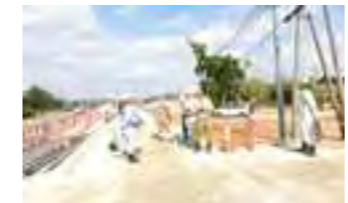
宜野座交差点改良工事
