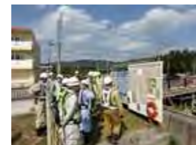
パトロール実施後の現場講評
