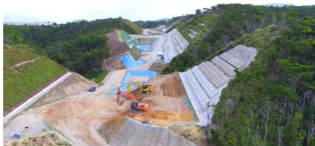
現場空中写真 バックホウ(黄色)が ICT 建設機械
