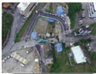
町道切り回し道路全景!
