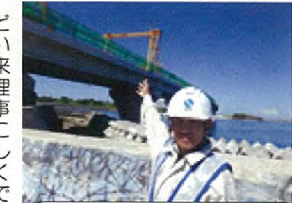
初めての配属現場!港川高架橋
