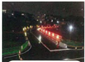
切り回し道路夜間照明安全対策
