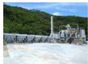
アスファルトプラント
