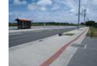
琉球石灰岩舗装
