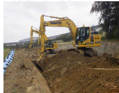
土工事ICT施工状況
