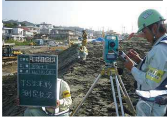
TSを用いた出来形測定状況(カッコいいね~!)
