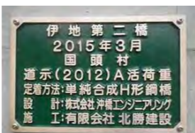
伊地第二橋の銘板!
