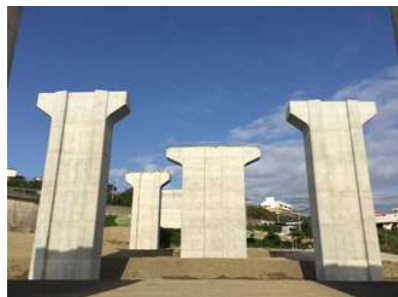
下部工P2工事完了しました！
