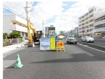
二車線交通規制状況
