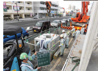
特殊部製品設置状況
