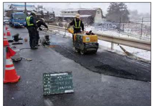
【車道の沈下処理(宮城・富谷町)】
