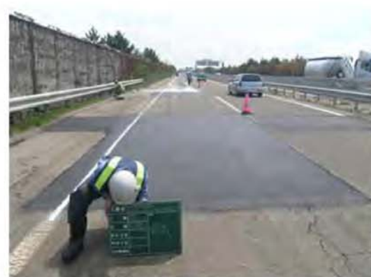
写真-6 段差すり付け(着工後)
