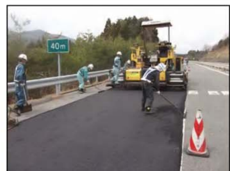
【磐越道 段差修正】
