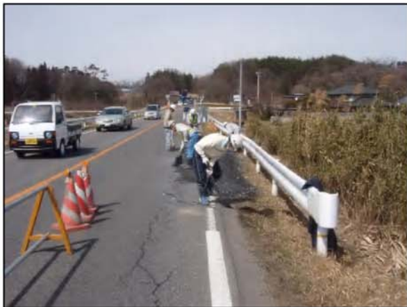
【一般国道 118 号(福島・玉川村)】
