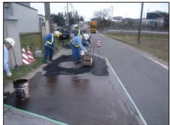
【マンホール段差処理(宮城・大和町)】
