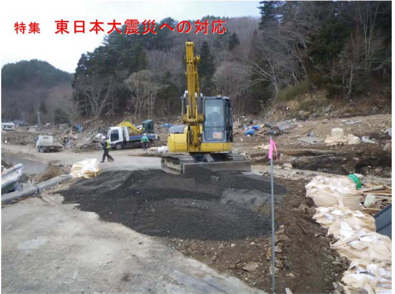
(宮古市重茂地内 道路復旧 H23/3/20)
