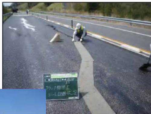
【常磐道 クラック処理状況】
