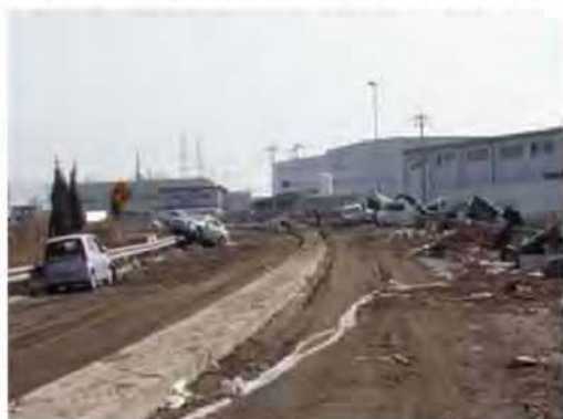
写真-2 仙台港北ICの津波による被害 1)
