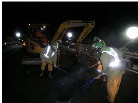
【東北道 段差修正】
