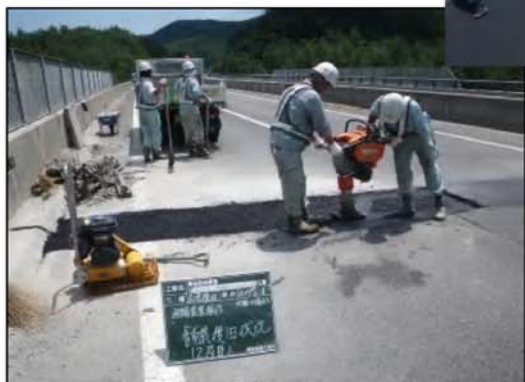
【磐越道 ジョイント補修】
