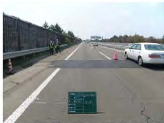
写真-5 段差すり付け(着工前)
