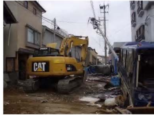
【宮古市鉄ヶ崎地内 3/15】
