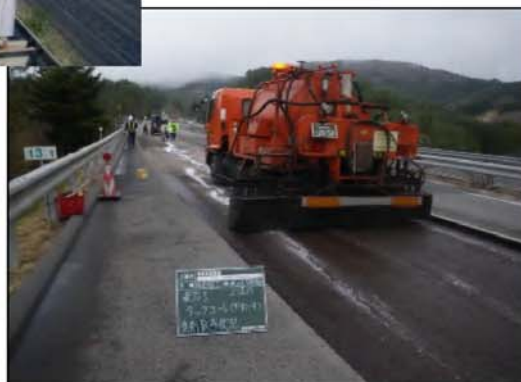
【磐越道 段差修正】
