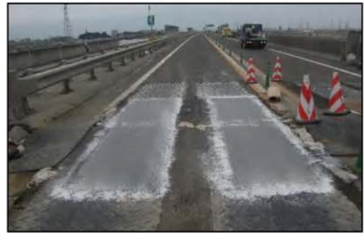
【仙台東部道路 敷鉄板補修】
