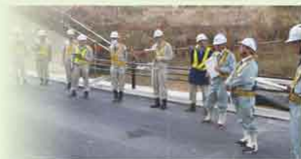
転圧作業最後尾
