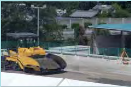
3Dマシンコントロールシステム 碎石敷均しフィニッシャー
